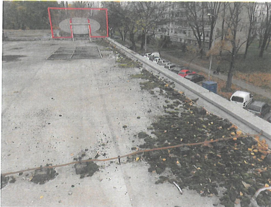
Ravni krov koji treba očistiti, pregledati HI foliju i sofone, zamijeniti opšave i gromobransku traku
