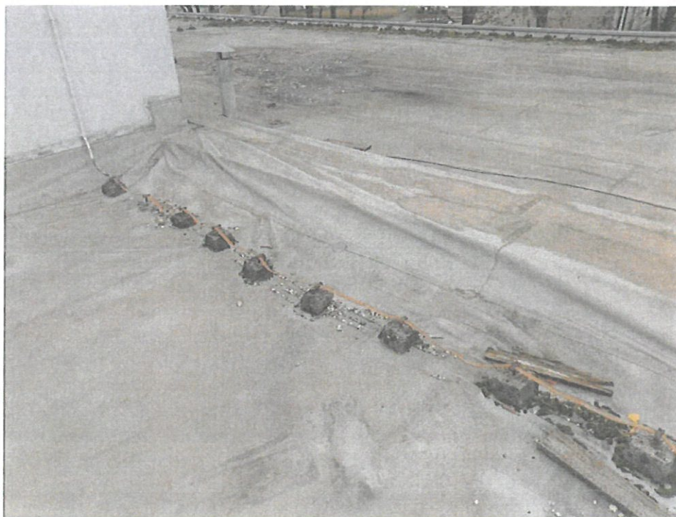
Ravni krov koji treba očistiti, pregledati HI foliju i soffone, sanirati oštećena mjesta, zamijeniti opšave i gromobransku traku
