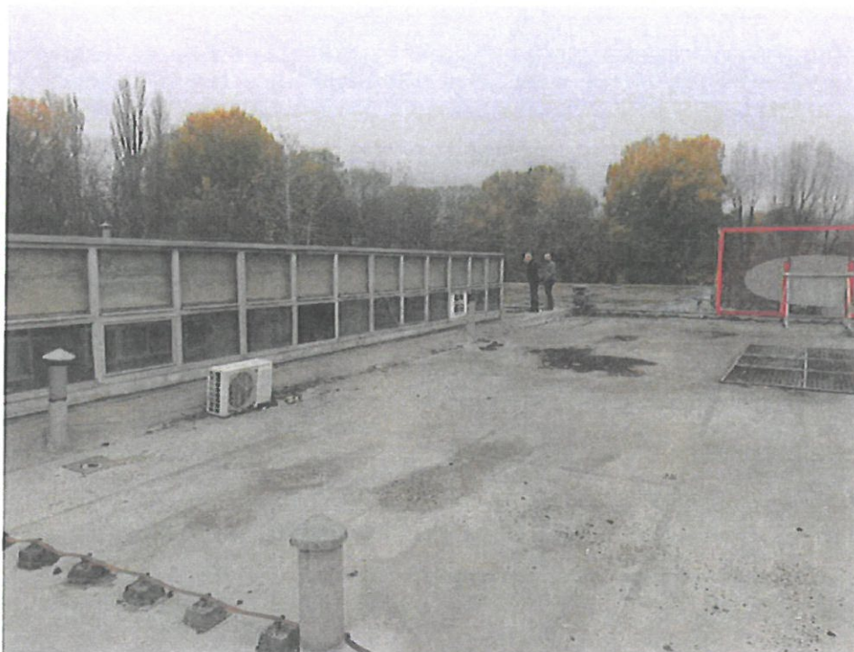
Ravni krov koji treba očistiti, pregledati HI foliju i soffone, zamijeniti opšave i gromobransku traku
