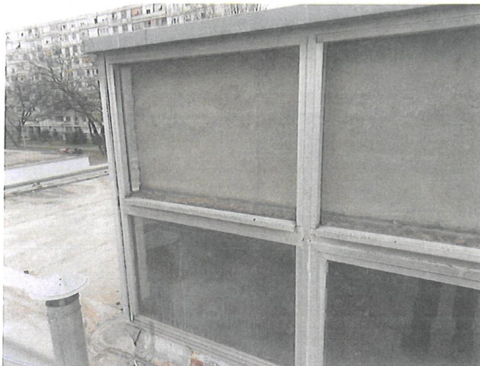
Aluminijska bravarija na uvučenom dijelu objekta na ravnom krovu, kroz stijenke bravarije voda ulazi u unutrašnjost objekta
