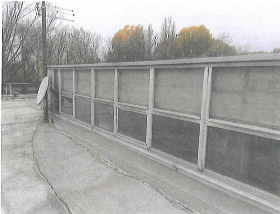
Aluminijska bravarija na uvučenom dijelu objekta na ravnom krovu, kroz stijenke bravarije voda ulazi u unutrašnjost objekta
