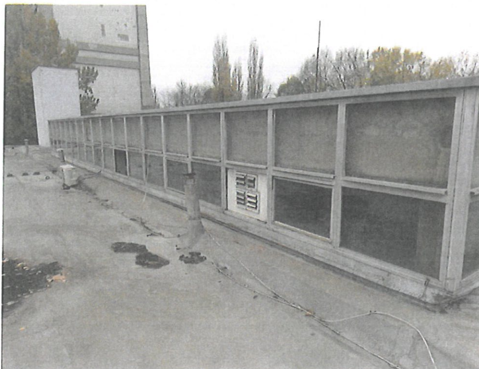
Aluminijska bravarija na uvučenom dijelu objekta na ravnom krovu, kroz stijenke bravarije voda ulazi u unutrašnjost objekta
